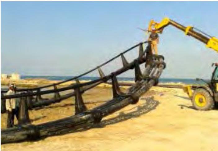
Figura 5. Jaula terminada siendo trasladada al mar
