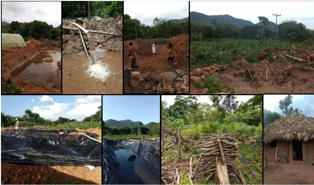
Figura 11. Proceso de construcción de los estanques y material para fijación de perifiton.
