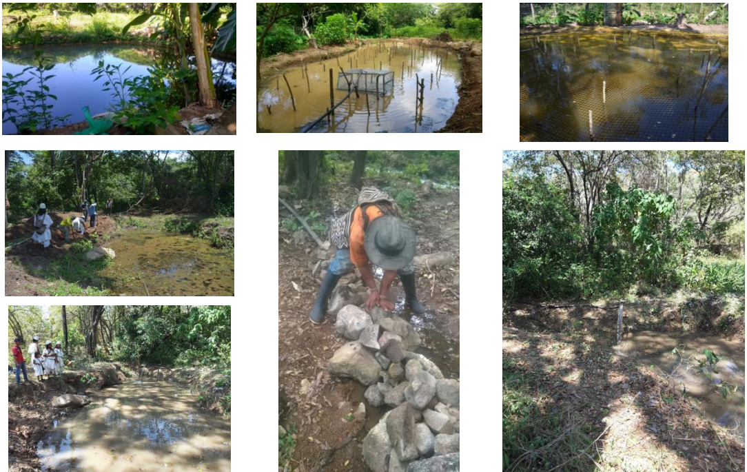
Figura 6. Actividades de adecuación para la instalación de SAAI EN Jimaín.
